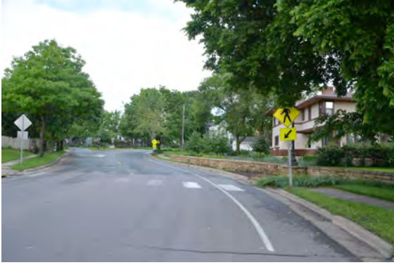
Figure 41. Kasota Stone retaining walls along Como Avenue (Nagasaki Rd), west of Lake Como.
