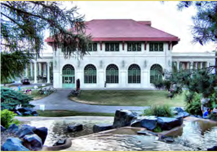
Como Lakeside Pavilion. Photo: Steve Sundberg / CC BY-NC-ND
