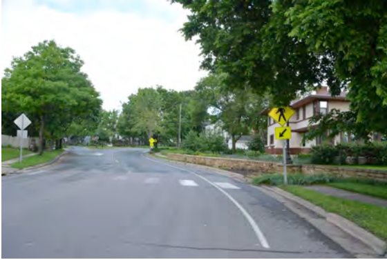
Figure 41. Kasota Stone retaining walls along Como Avenue (Nagasaki Rd), west of Lake Como.
