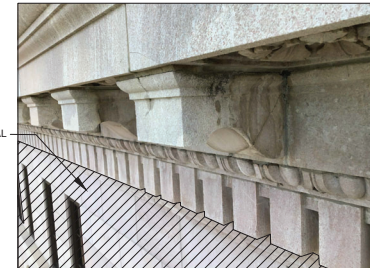
8 STONE MODILLON PINNING A3.2 SCALE: N.T.S.
