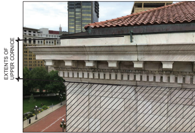
2 UPPER STONE CORNICE - NORTHWEST CORNER A3.1 SCALE: N.T.S.
